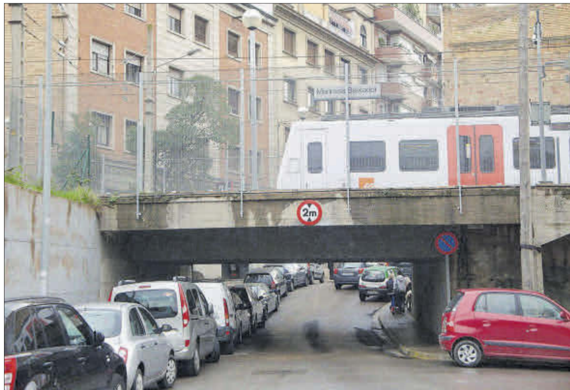
El projecte elimina el coll d'ampolla del carrer de Camps i Fabrès fent el baixador subterrani ARXIU/JORDI MORROS
