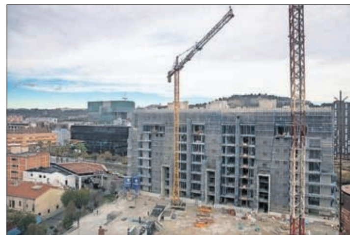
Un proyecto de viviendas en la Zona Franca, en obras. /M.M.
