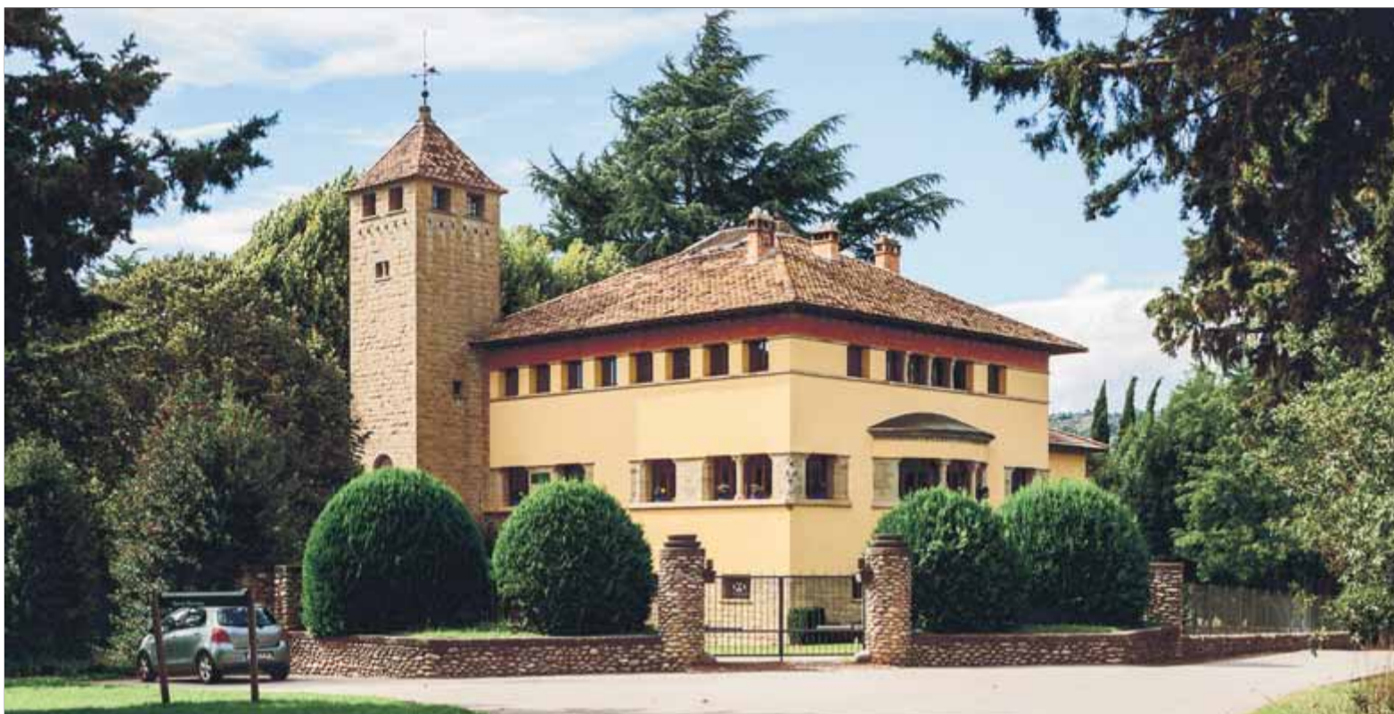
La finca La Coromina, de Torelló, una de les obres de l'arquitecte osonenc Josep Maria Pericas ■ LLUÍS CASALS
