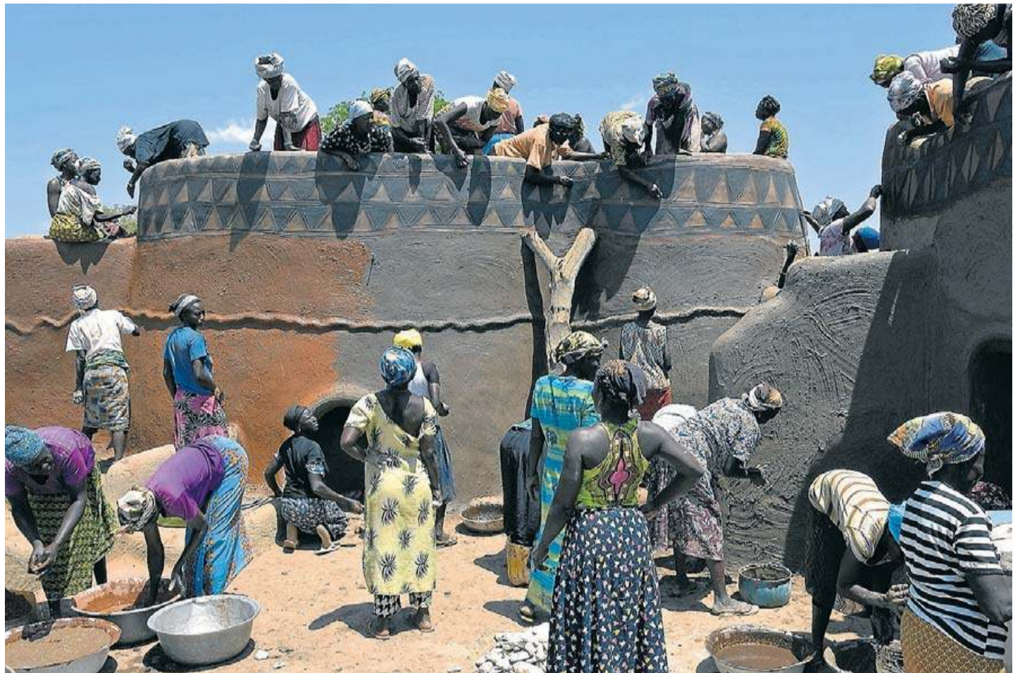
Més de cent dones van treballar en la recuperació dels arrebossats al poblat de Tangassogo. TONI CUMELLA / MUSEU DE GRANOLLERS
