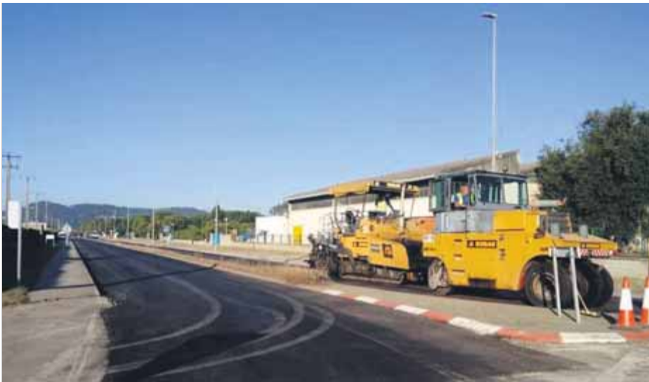
Els treballs de millora que es van dur a terme l'any passat al carrer Ter ■ AJUNTAMENT DE CELRÀ
