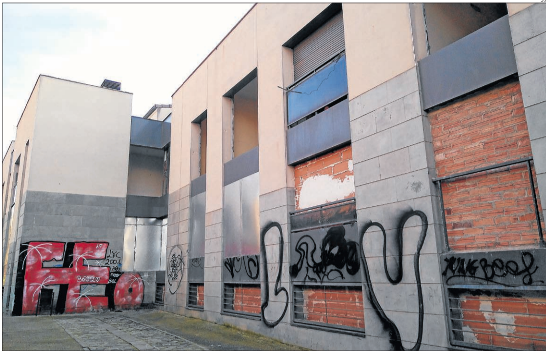
La part posterior de l'edifici, ara tapiat amb totxos i planxes metàl·liques.
